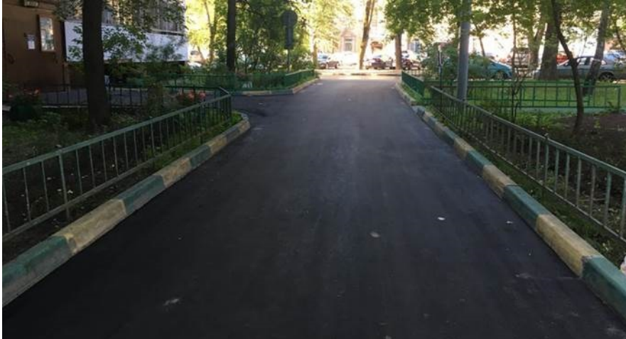
Будайская ул., дом 5
